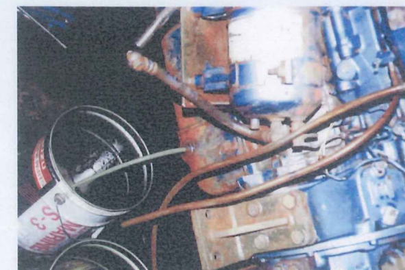
エンジンオイルの点検
